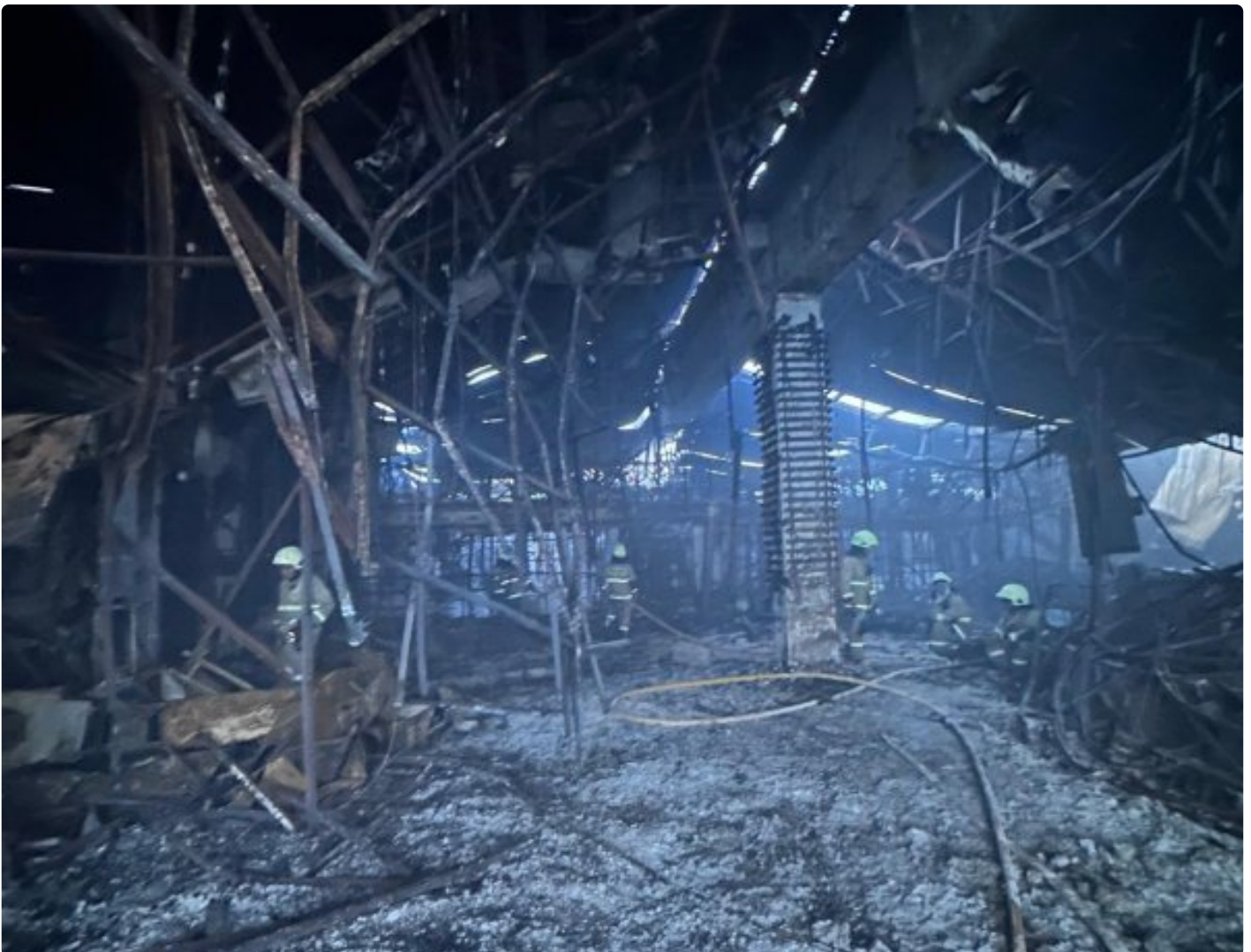
Glodok Plaza yang Hangus Terbakar
